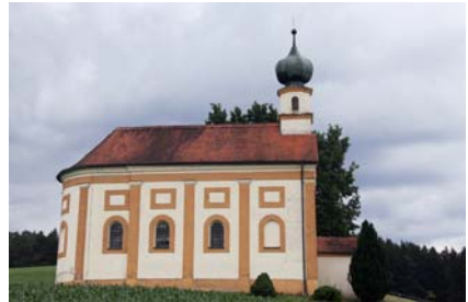
Fialkirche St. Corona, Niederaich
